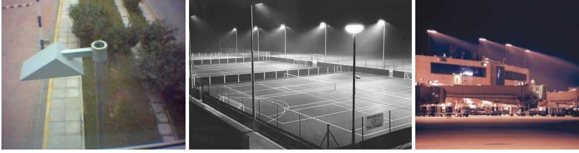
Şekil 7. Tam perdeli armatür örnekleri – doğru uygulamalar.
