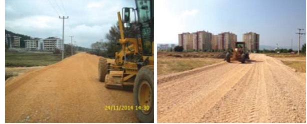
Yol Açma -Malzeme Serme Çalışmaları
