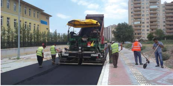
Asfalt Kaplama Çalışmaları
