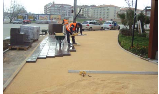
Bordür tretuvar çalışmaları
