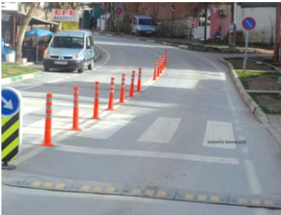
Hız Kesici ve Delinatör Uygulaması
