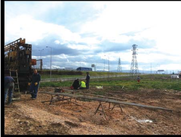
Nilüfer Belediyesi - Görükle Spor Parkı Tırmanma Duvarı Yapı İnşaatı
