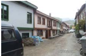
Pınar sokak sağ cephe uygulamadan sonraki hali
