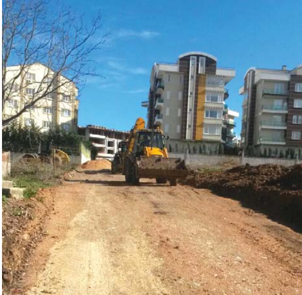
Şantiye Yol açma- malzeme serme çalışmaları
