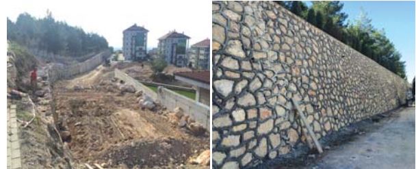
Betonarme Duvar Çalışmaları
