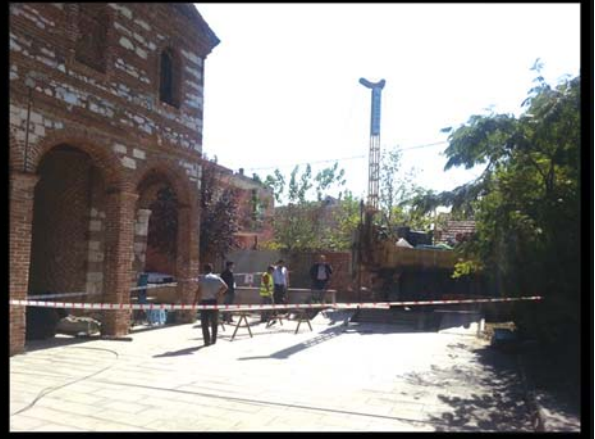
Özlüce Kültür Evi Zemin Kaynaklı Yapı Hasarlarının Çözümlemesine Yönelik Zemin Araştırmaları Projesi
