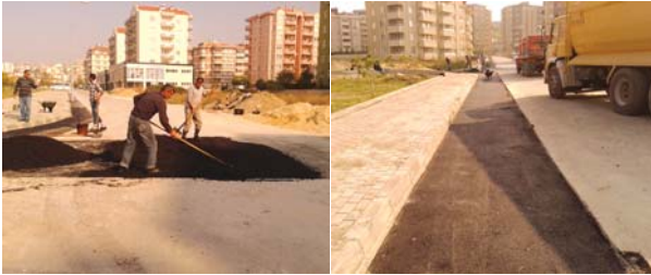
Asfalt Yama Çalışmaları
