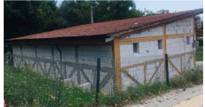
12- İhsaniye Mahallesi Oyun Engel Tanıma Parkı içerisinde bulunan çocuk meclis evi dış cephesine yitong döşenerek sıva ve boya yapıldı.
