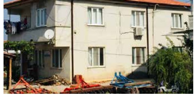
10- Fadıllı Mahallesi mevcut muhtarlık odası yapının alt katına taşınarak gerekli WC ve mutfak tadilatları yapılmış ve yapının tamamında iç cephe boya imalatları yapıldı.
