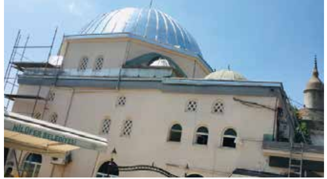
30- Badırğa Mahallesinde cami yanında yer alan tuvaletlerin çatı kaplaması yenilenerek dış cephe boyası yapıldı.
